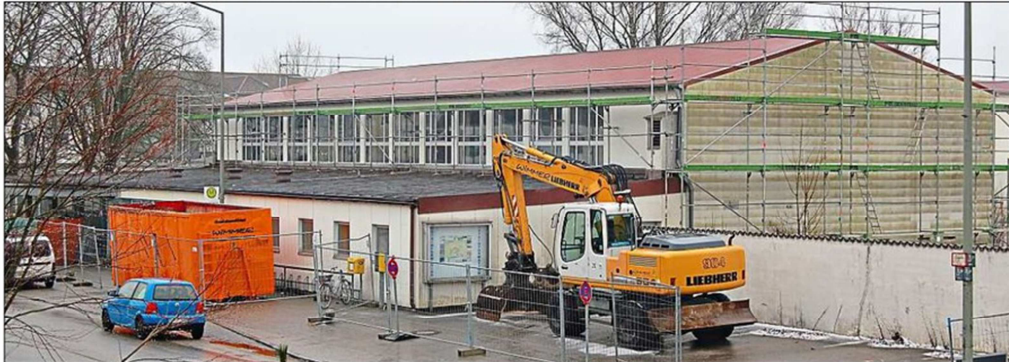
Der Abbruchbagger steht schon bereit, ein Bauzaun umschließt die Turnhalle und die Container warten auf Material: Die Comenius-Sportstätte gestern Vormittag. – Fotos: Brandl
