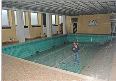
Mit einem Vorschlaghammer über der Schulter ist ein Arbeiter im einstigen Hallenbad der Schule. Ganze Generationen haben hier Schwimmen gelernt – jetzt wird das Becken verfüllt.
