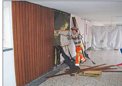
Das Trennen der Materialien ist eine wichtige Arbeit vor dem eigentlichen Abbruch: Gestern riss dieser Arbeiter Holzverkleidungen und Wärmeschutz-Matten aus der Wand im Gang.
